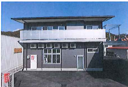
庁舎全景 (南から)
