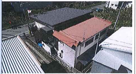
庁舎全景 (北東から)
