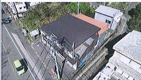
庁舎全景 (南東から)
