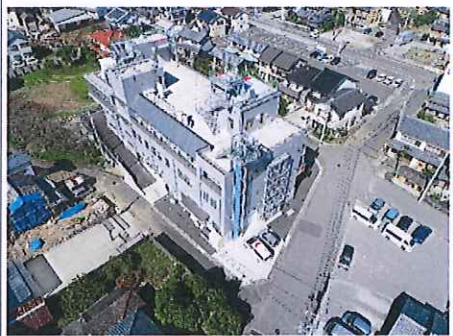
庁舎全景 (南東から)
