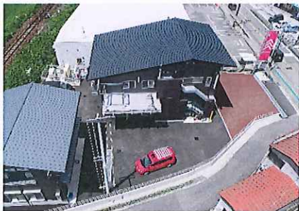
庁舎全景 (東上空から)
