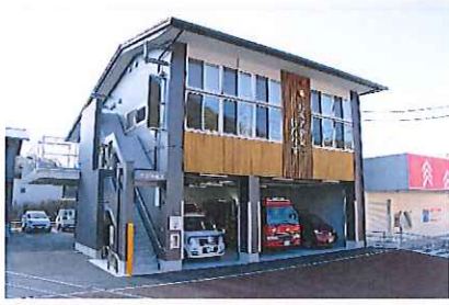
庁舎全景 (北東から)
