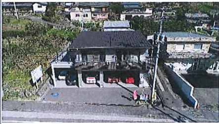
庁舎全景 (南から)
