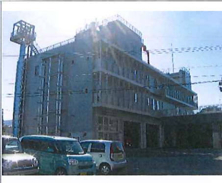
庁舎全景 (北東から)
